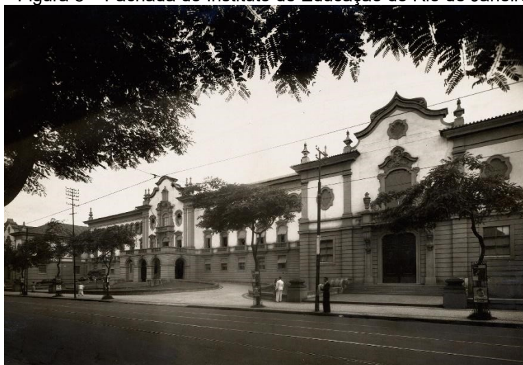
Figura 8 – Fachada do Instituto de Educação do Rio de Janeiro
